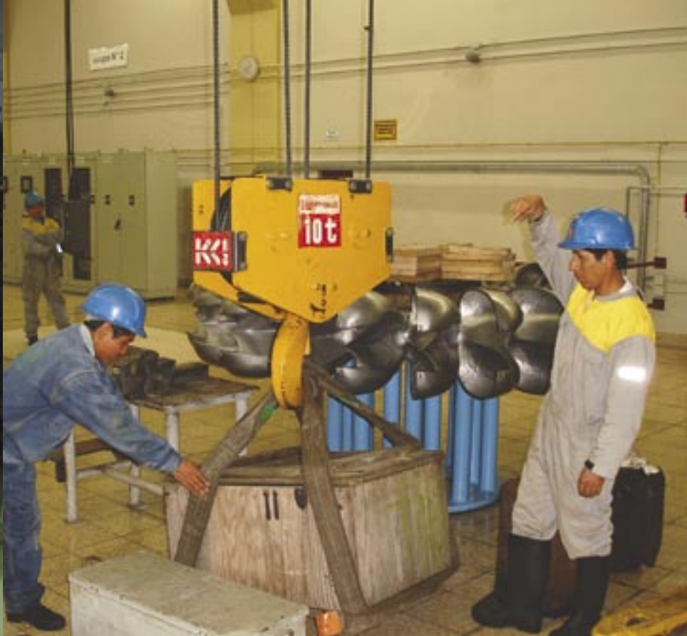
Trabajo de mantenimiento en la CHSGBII / Maintenance work in CHSGBII
