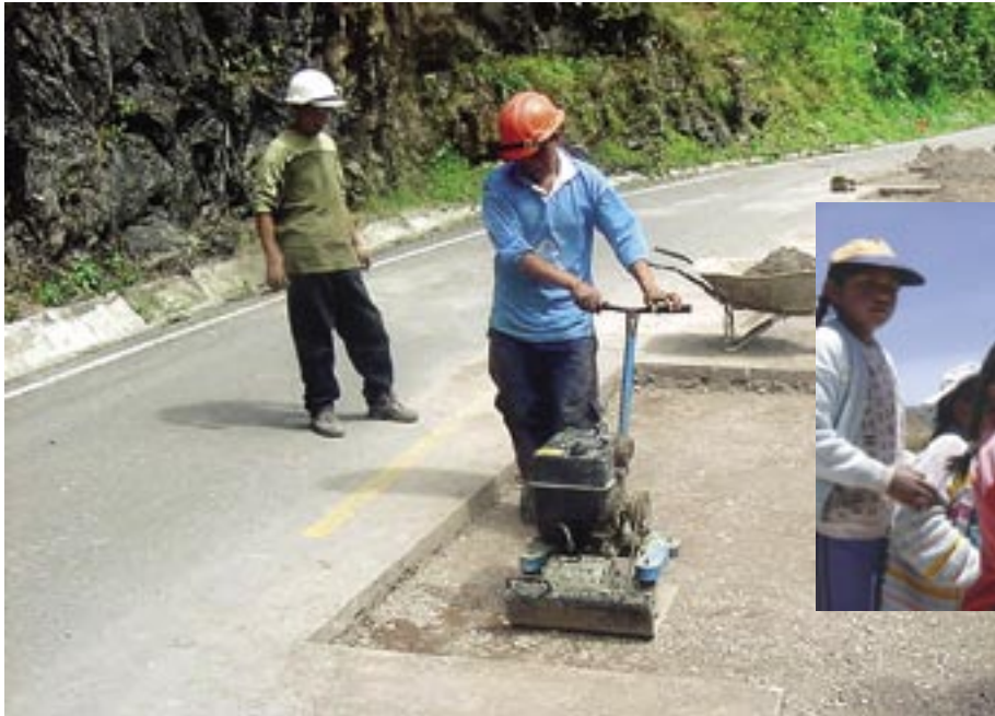
Mantenimiento pista Chauni Tunquini Chauni Tunquini pave road maintenance
