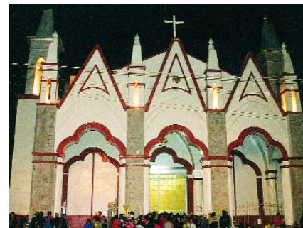
Frontis de la Iglesia San Juan. San Juan church.
