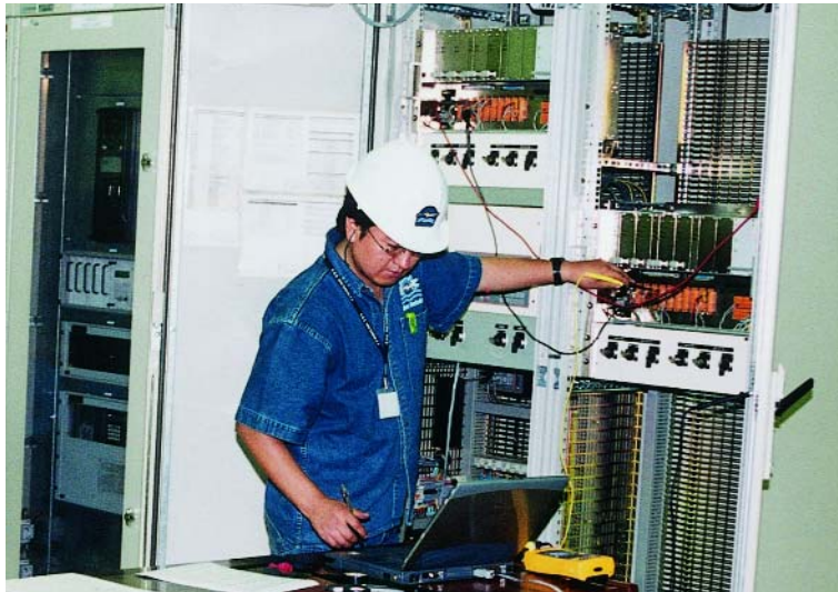
Programación y prueba del tablero de comunicación. Communication board programming and testing.
