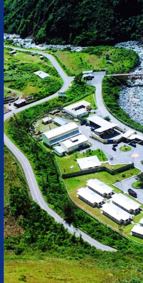
Vista panorámica de la bocatoma, embalse y oficina administrativa de la C.H. San Gabán. General View of in-let, Reservoir and Administrative Office, C.H. San Gabán II.
