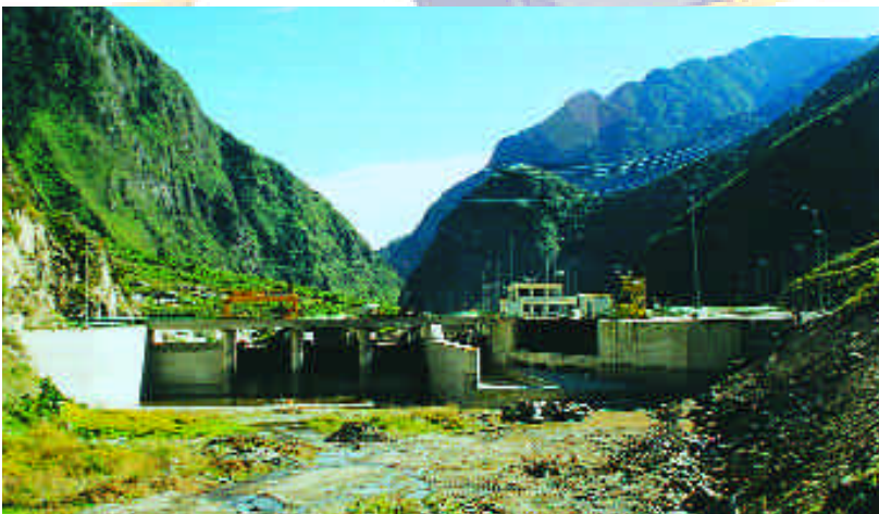
Obras de cabecera: Vista General de la presa Aguas Arriba. Head works: Up stream general view
