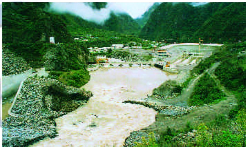
Obras de Cabecera de la C.H. San Gabán II Head works of the S.G.H. P.S. San Gabán II
