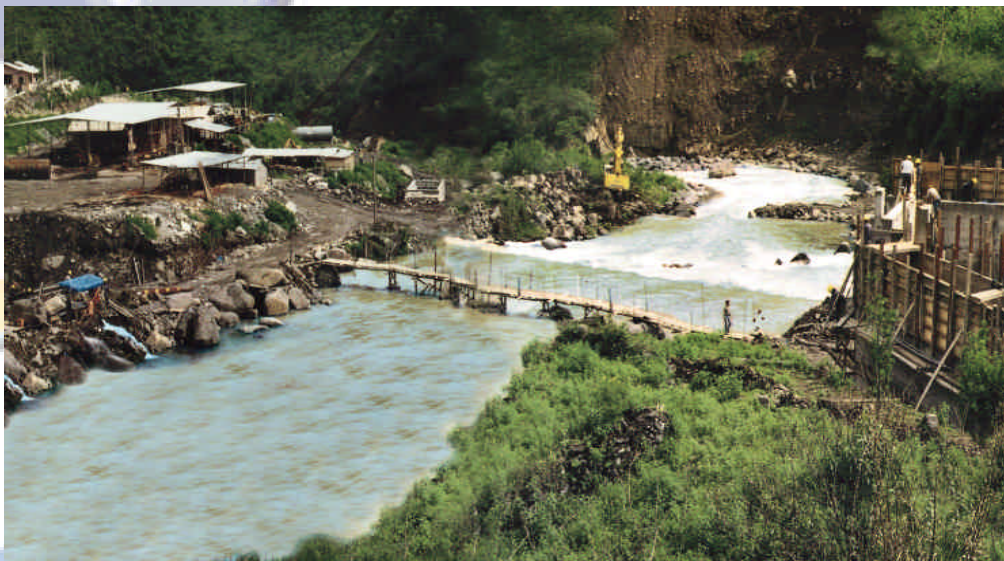
Antiguo Puente de acceso a zonas de obras de cabecera, trabajos para bases de nuevo puente (1995) Former access bridge works for the foundations of the new bridge (1995)
