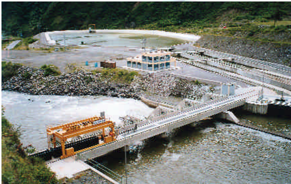
Lote 1: Obras de Cabece- ra de la C.H. San Gabán II Lot 1: Headworks of San Gabán II H. P.S.
