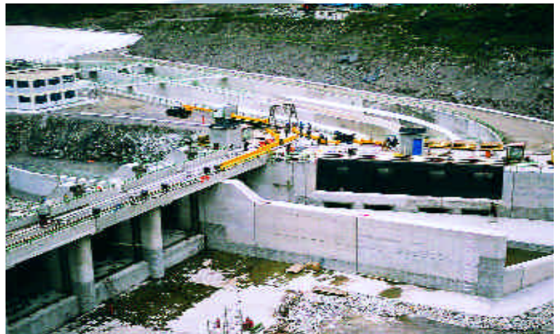
Lote 1: Obras Concluidas de Cabece- ra de la C.H. San Gabán II Lot 1: Finished Headworks of San Gaban II H. P.S.
