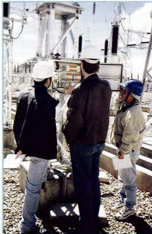
Subestación Azángaro. Instalación del sistema de onda portadora. Marzo 1999. Azangaro Sub Station. Power line carrier system installation. March, 1999.
