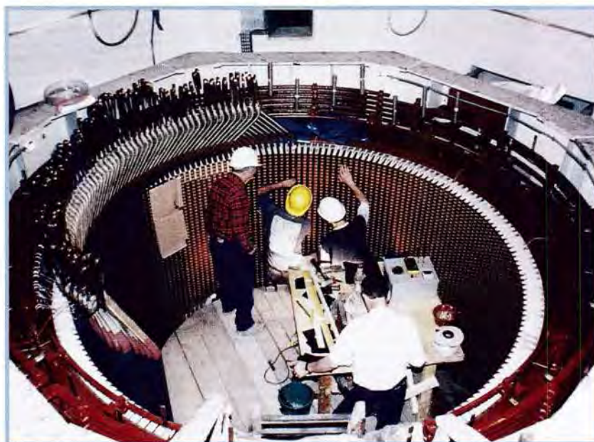
Armado del estator de la unidad N° 1. Junio 1999. Assembly of stator of Unit N° 1. June 1999
