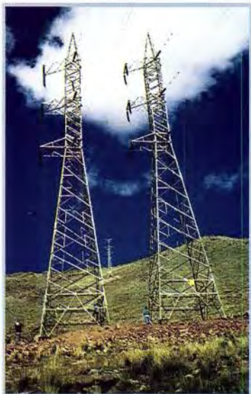
Montaje de estructuras y conductores. Zona San Antón. Structures and conductors erection. San Anton area.
