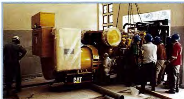
Montaje de grupos generadores. Subestación San Gabán II. Marzo 1999. Assembly of Power Generator for ancillary services. San Gabán II Sub Station. March, 1999.
