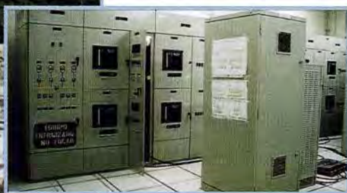
Equipamiento mecánico, electromecánico, hidromecánico de la central. Pruebas de equipos principales. Diciembre, 1999.
