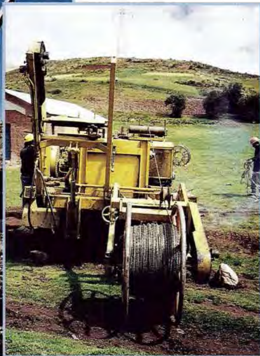
Tendido del cable fibra óptica tramo de estructura 274 a 281. Marzo 1999. Section from 274 to 281 structure; Fiber Optic Cable installation. March, 1999.
