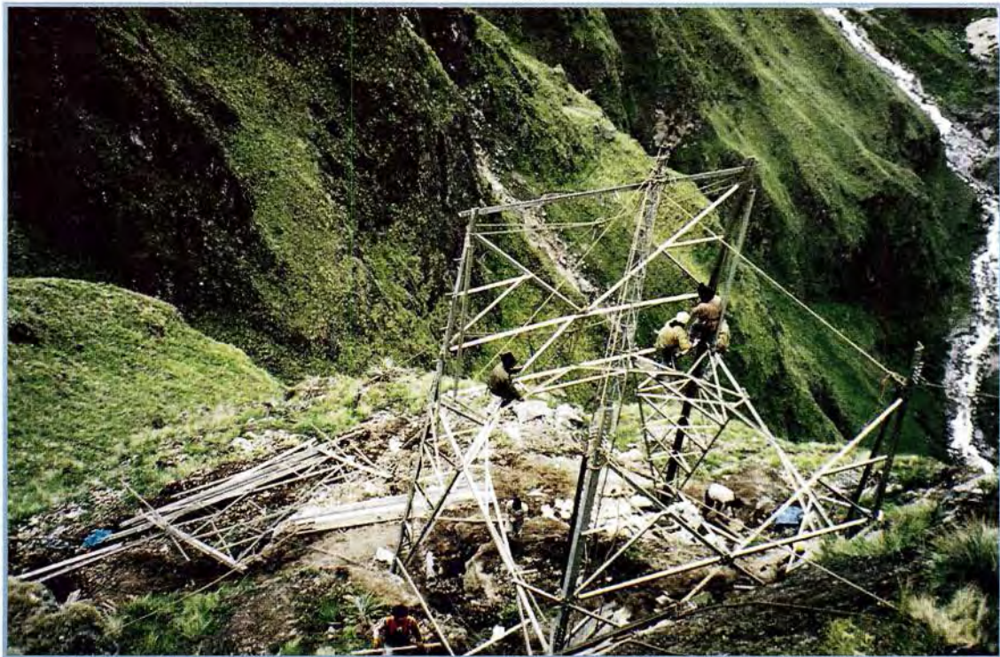
Montaje de estructura N° 31. Abril 1999. N° 31 Structure assembly. April, 1999.
