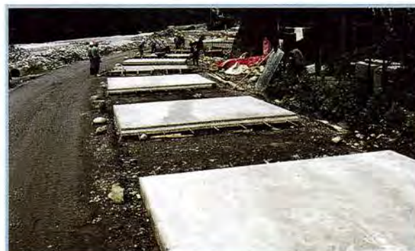
Descarga norte. Pavimentación del tramo de carretera frente a la antigua descarga con concreto. North discharge. Road concrete paving of the section in front of the old section of the discharge tunnel.
