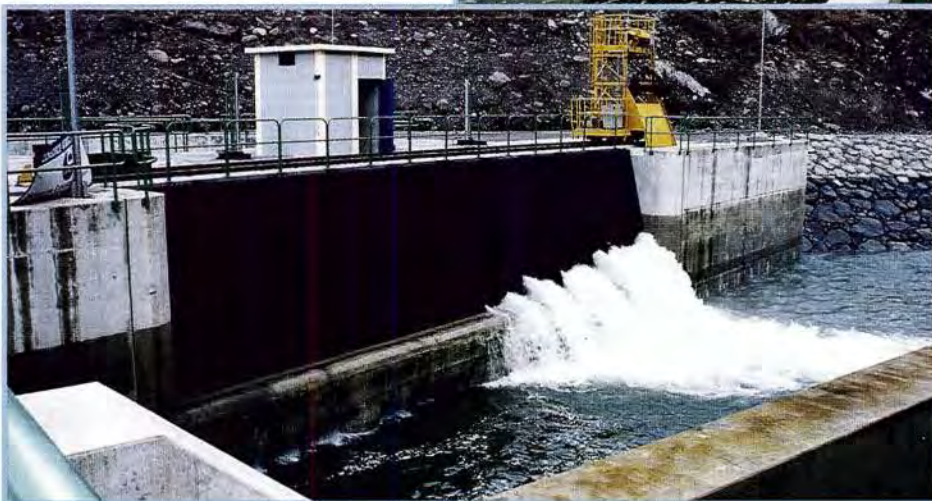
Prueba de descarga de nave de desarenadores en contraflujo Testing discharge bay of sand traps in counterflow.
