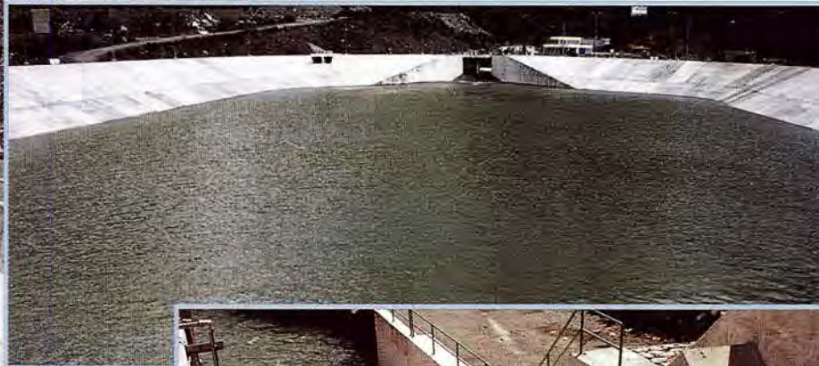
Pruebas pre-operativas. Llenado del embalse. Pre-operation tests. Reservoir water filling.
