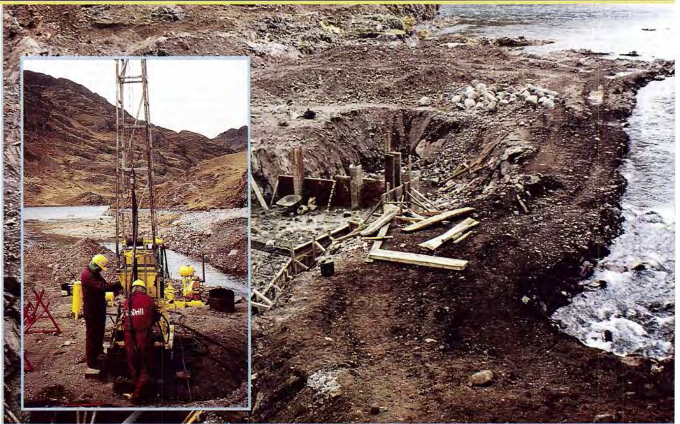
Embalse Cinco Lagunas. Presa Chaumicocha. Instalación del equipo de perforación. Five Lagoons Reservoirs. Chaumicocha's dam. Installation of the perforation equipment.
