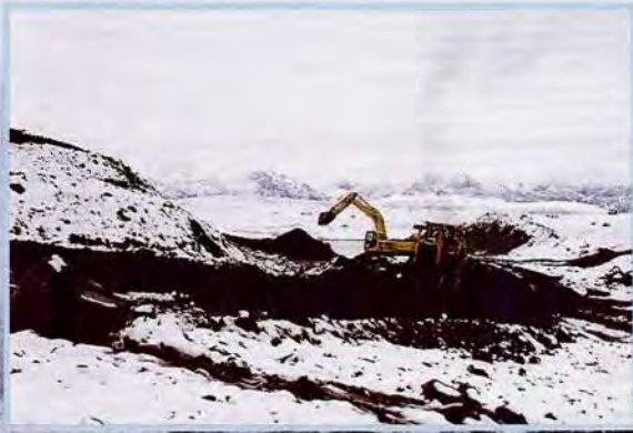
Embalse Parinajota. Vista de la presa Principal. Diciembre 1999. Parinajotas' reservoir. Main dam view. December 1999.
