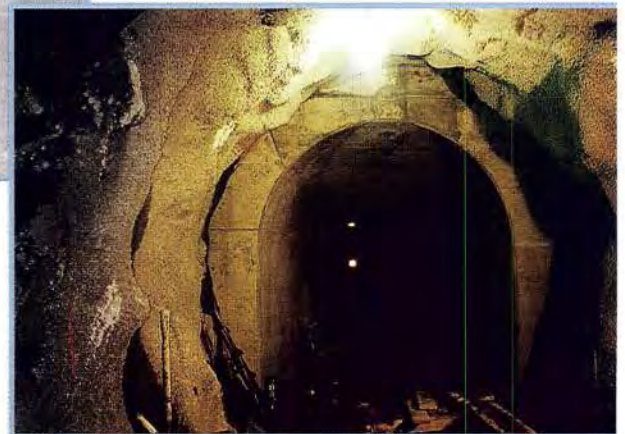
Túnel de Aducción y obras conexas. Tapón de ventana Uruhuasi. Vista exterior. Adduction Tunnel and related works. Uruhuasi's Access Tunnel stopper. Outside view.
