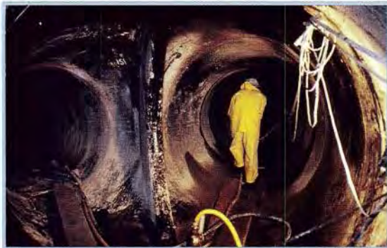
Conducto blindado. Zona del bifurcador. Reinforced tunnel. Bifurcation area.
