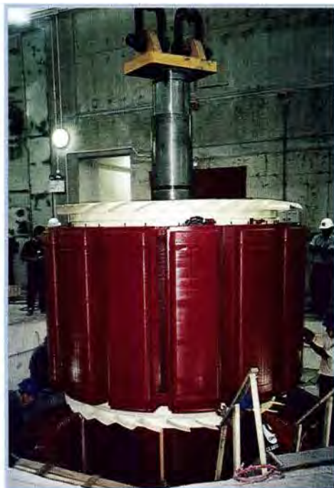
Casa de máquinas : Instalación en pozo del rotor Grupo N° 1. Setiembre 1999. Power House : Installation of the Rotor pit in Group N° 1. September, 1999.
