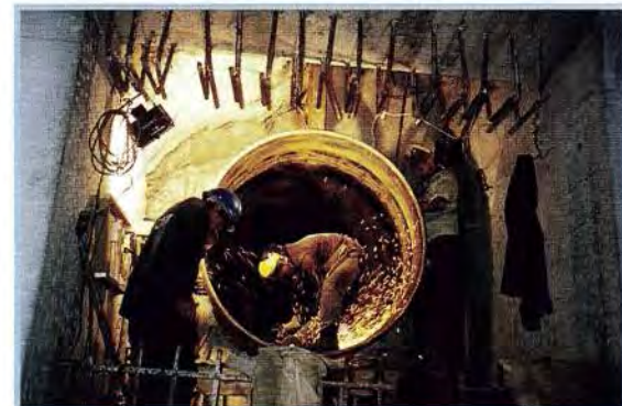
Trabajos previos al montaje de la válvula esférica N° 2. Prior jobs to the assembly of spherical valve N° 2
