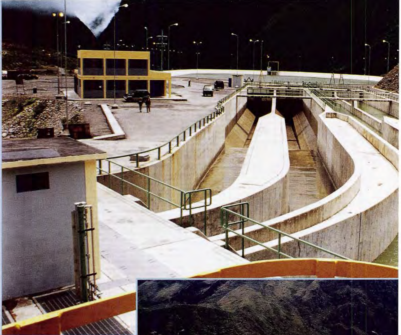
Desarenadores Sand traps.
