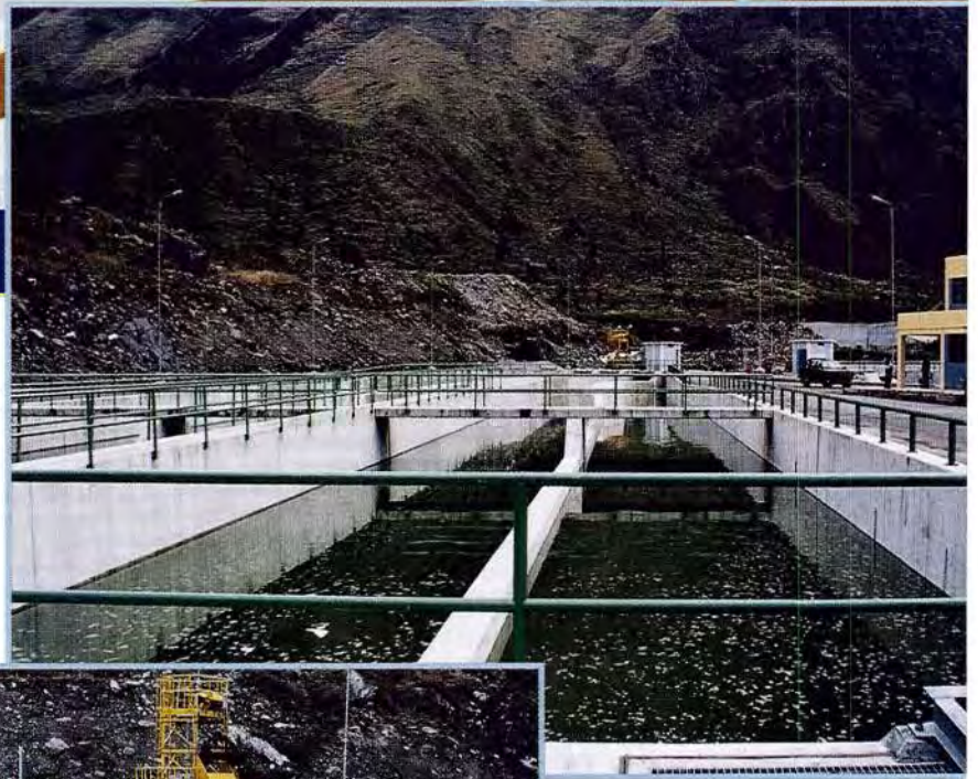
Vista general de los desarenadores General view of sand traps
