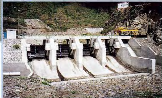
Presa Derivadora Dam
