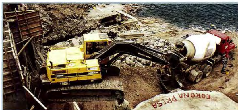
Embalse Cinco Lagunas. Construcción de la primera presa de concreto de Suytocochoa. Octubre 1999. Five Lagoons Reservoirs. Construction of the first Suytocochoa's concrete dam. October, 1999
