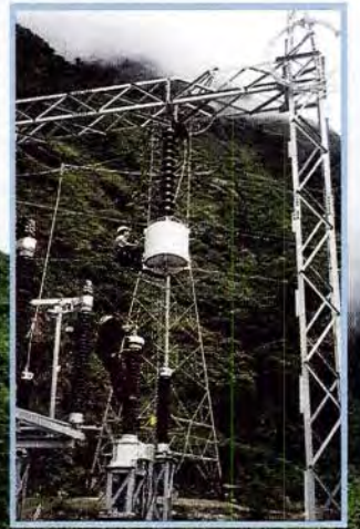
Montaje de Trampa de Onda. Mayo 1999. Assembly of Wave Trap. Trap, May, 1999.
